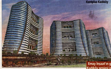
Emay İnşaat'ın gerçekleştireceği Kentplus Kadıköy projesi için dün son bina da yıkıldı.
